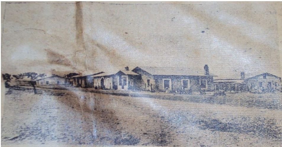
Colonia obrera "Incz."—Estas casas las construye la United Sugar Companies, S. A., para sus obreros, a quienes les abona el 50% de su costo, después que aquéllos han cubierto el otro 50% en 10 anualidades
